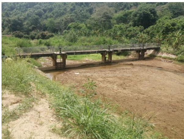
๒.๑ ขุดลอกหน้าฝายแม่ไร่ ประมาณ ๒๐๐ เมตร พิกัด ๕๕๗๒๙ E , ๒๒๔๒๕๖ N
