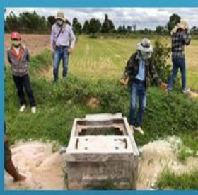
จุดปล่อยน้ำขนาดพองายน้ำ 2 นิ้ว จ่าย 2 ทาง ตำแหน่งห่างกัน 100 เมตร หรือตามที่เหมาะสม
