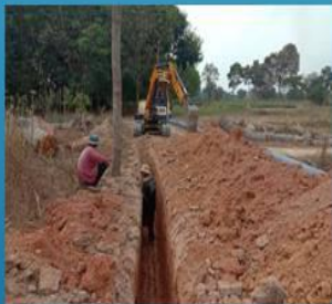
การวางท่อส่งน้ำลึกจากผิวดินประมาณ 1.00 เมตร
