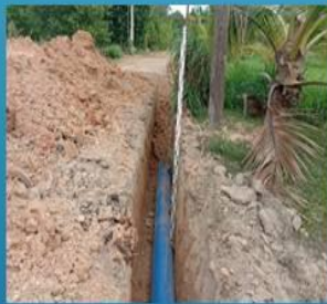
การวางท่อส่งน้ำลึกจากผิวดินประมาณ 1.00 เมตร
