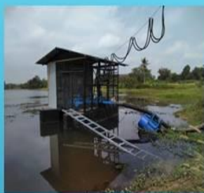
สถานีสูบน้ำแพเหล็ก 1 สถานี ป้อนน้ำขนาด 60 แรงม้า จำนวน 2 ตัว
