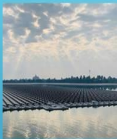
แผงโซลาร์เซลล์พลังงานแสงอาทิตย์ ติดตั้งบนทุ่นลอยน้ำ 336 แผง
