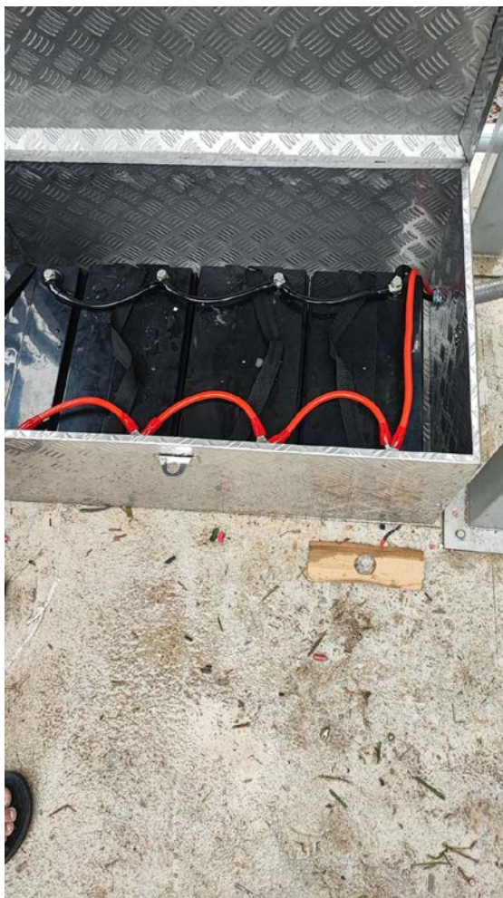
รูปที่ 3.8-8 การติดตั้งอุปกรณ์ Battery deep cycle gel
