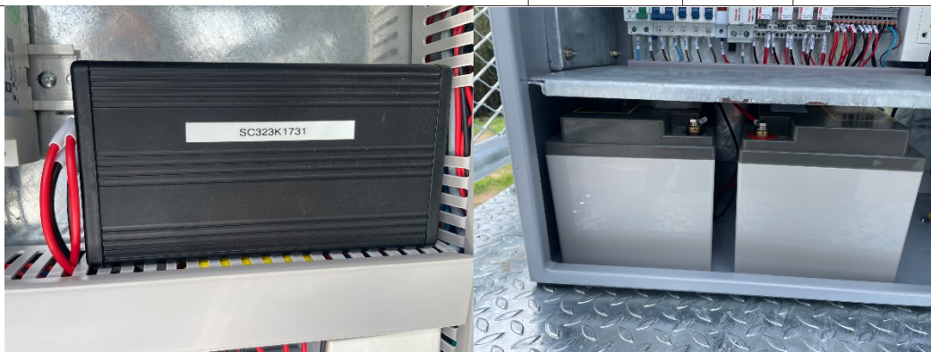
รูปที่ 3.7-4 การติดตั้งอุปกรณ์สำหรับเชื่อมต่อ
