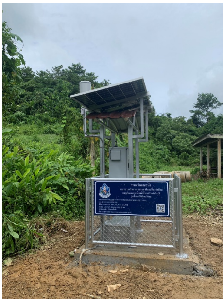
รูปที่ 3.8-2 การติดตั้งอุปกรณ์แผงโซลาร์เซลล์
