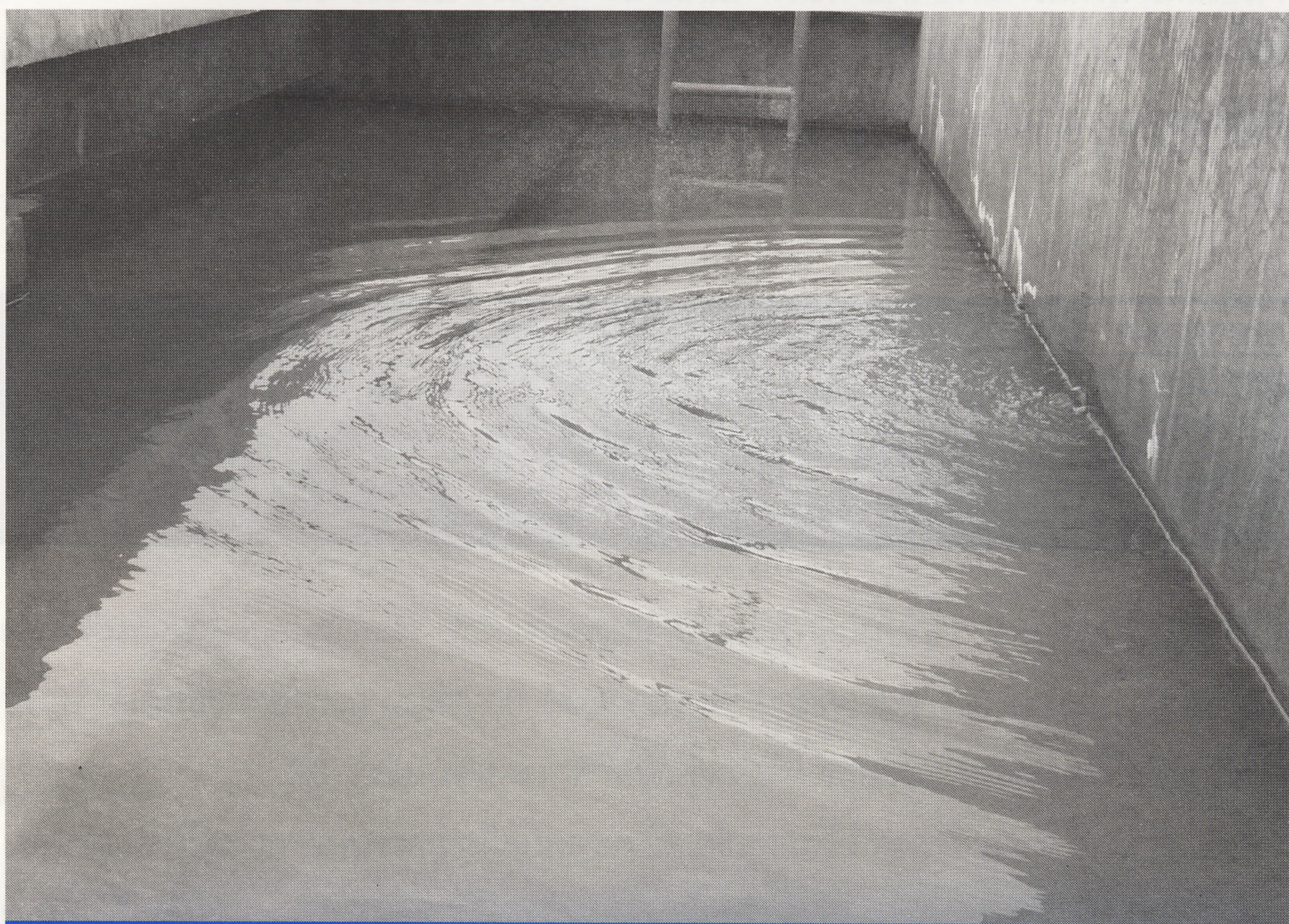
รูปที่ 28 การเกิดตะกอนในถังรวมตะกอน
