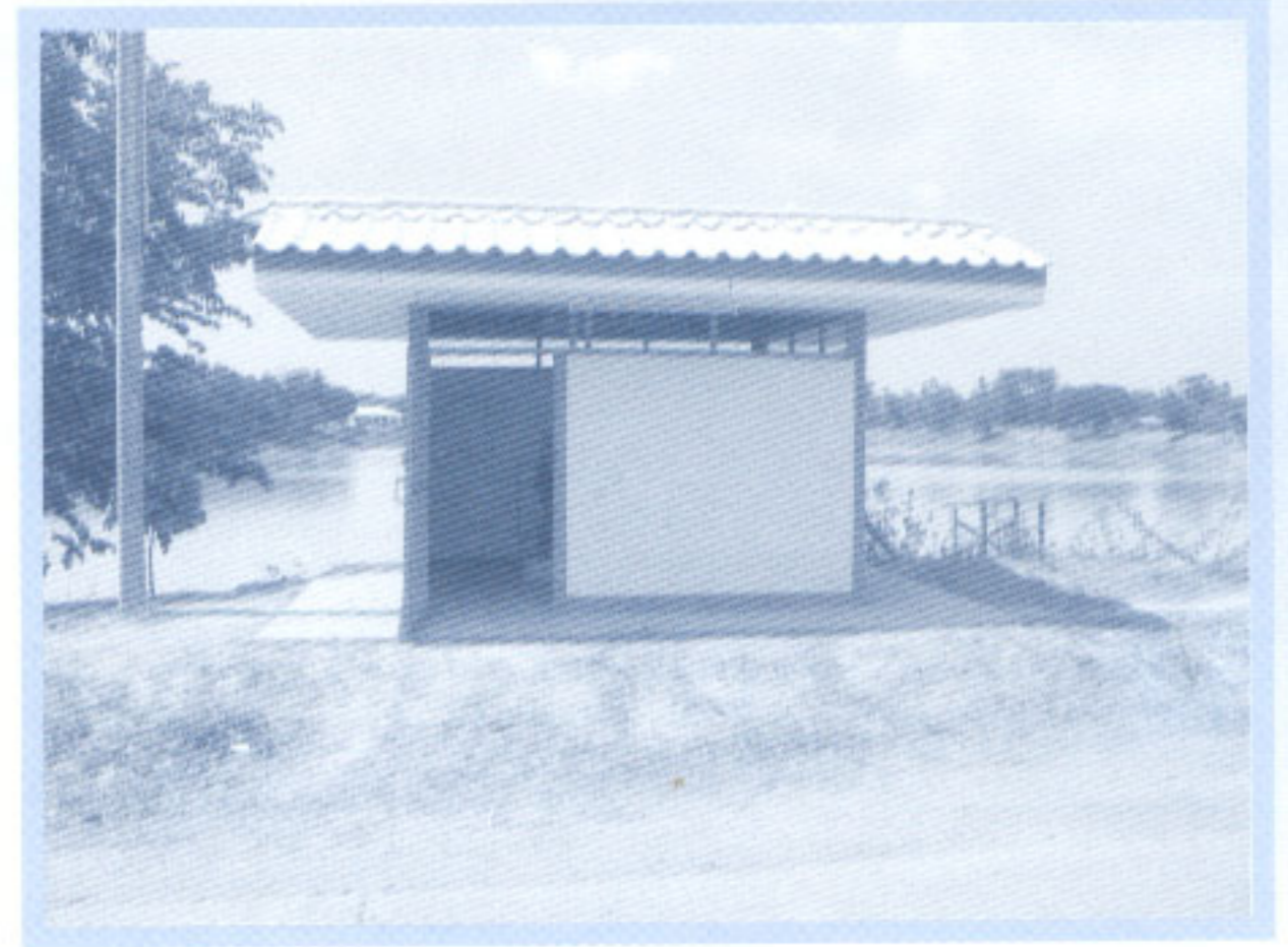
รูปที่ 3 เครื่องสูบน้ำดิบติดตั้งในโรงสูบน้ำ
