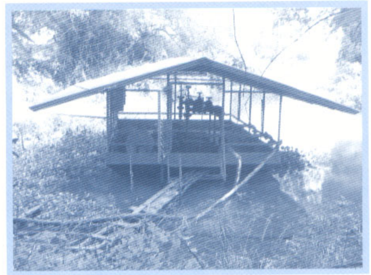
รูปที่ 4 เครื่องสูบน้ำดิบติดตั้งอยู่บนแพลอย
