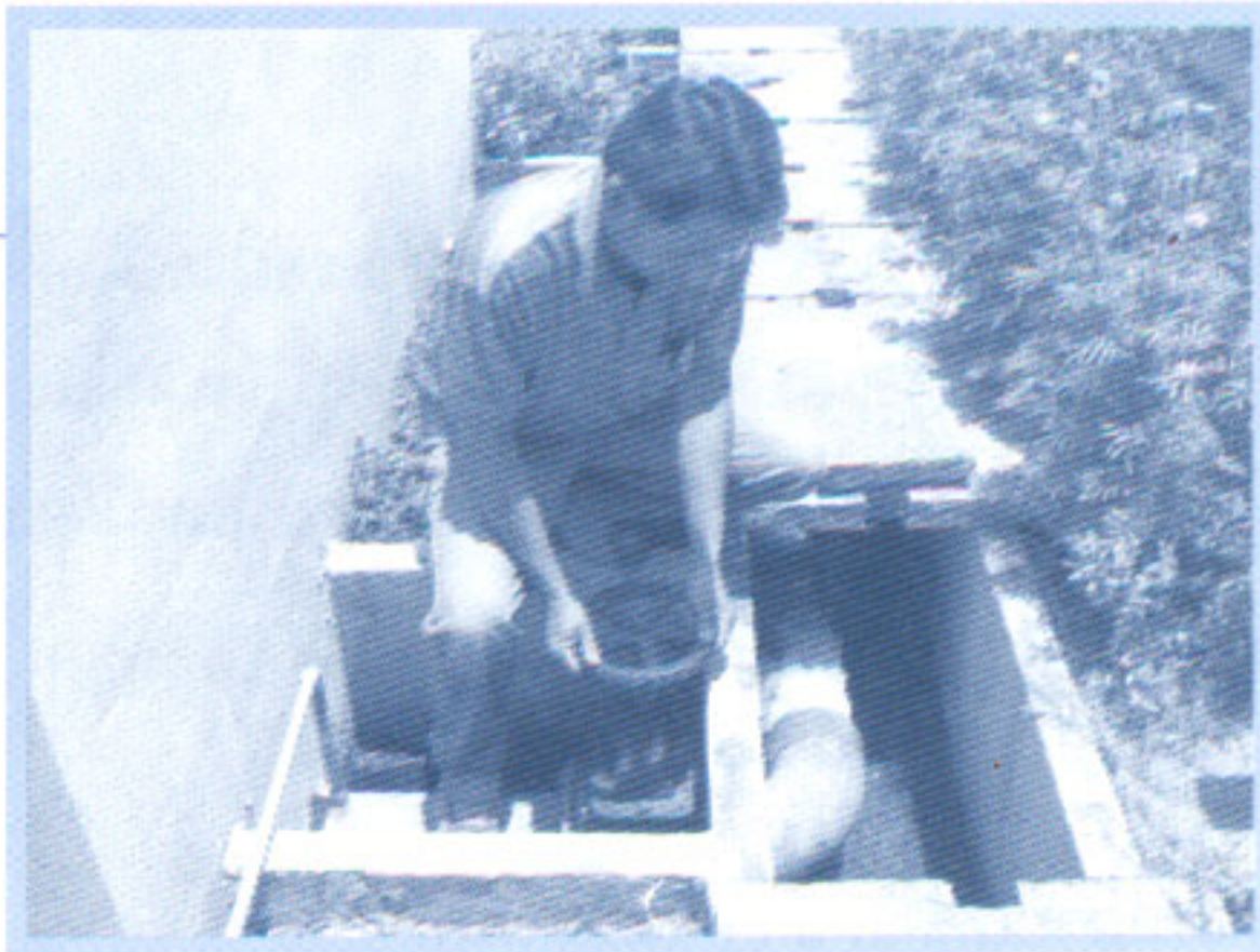
รูปที่ 60 เปิดประตูน้ำระบายตะกอนในถังกรอง (ประตูน้ำหมายเลข 5)
