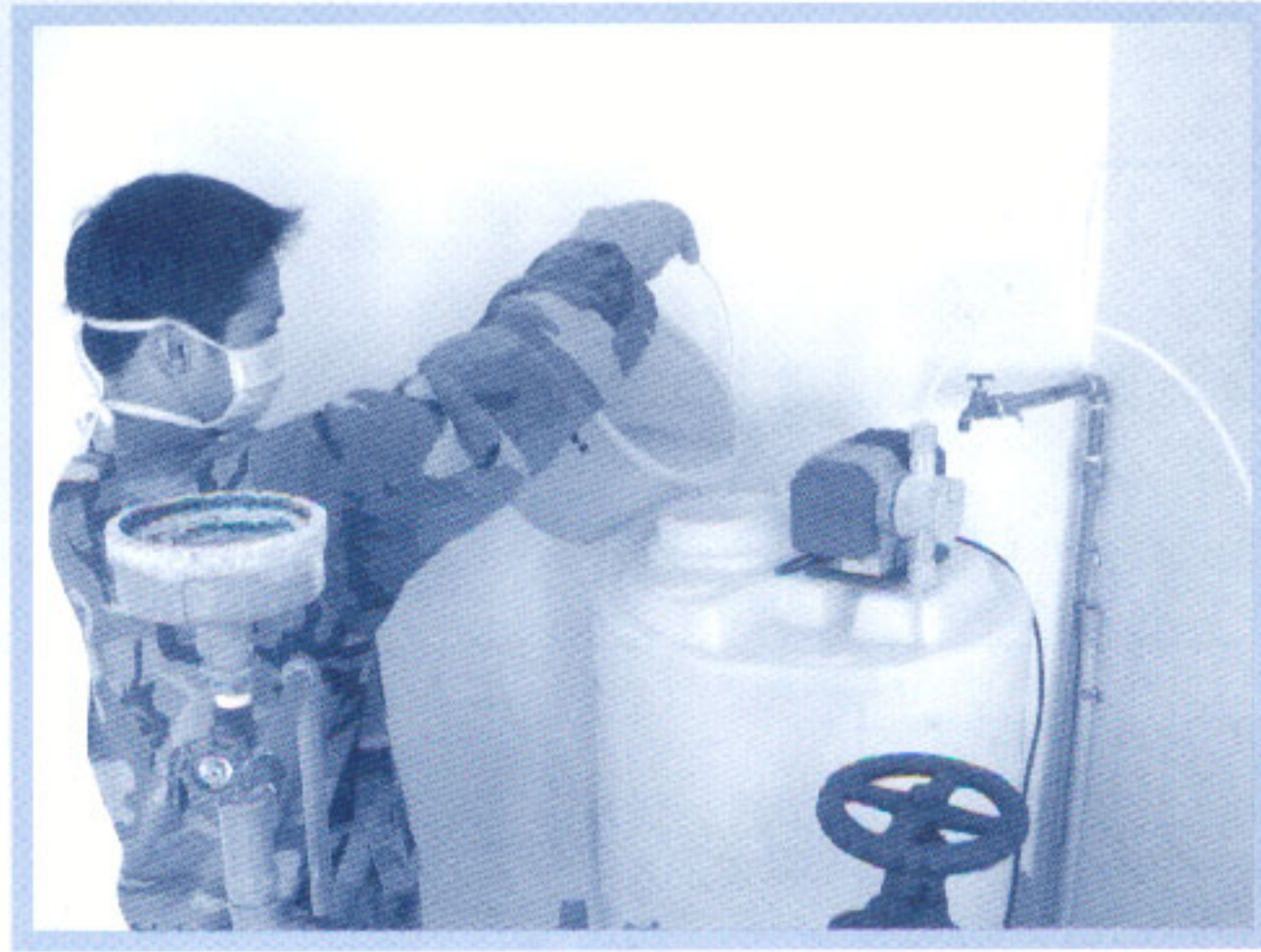
รูปที่ 43 การเติมสารละลายคลอรีนลงในถังจ่ายสารละลายคลอรีน
