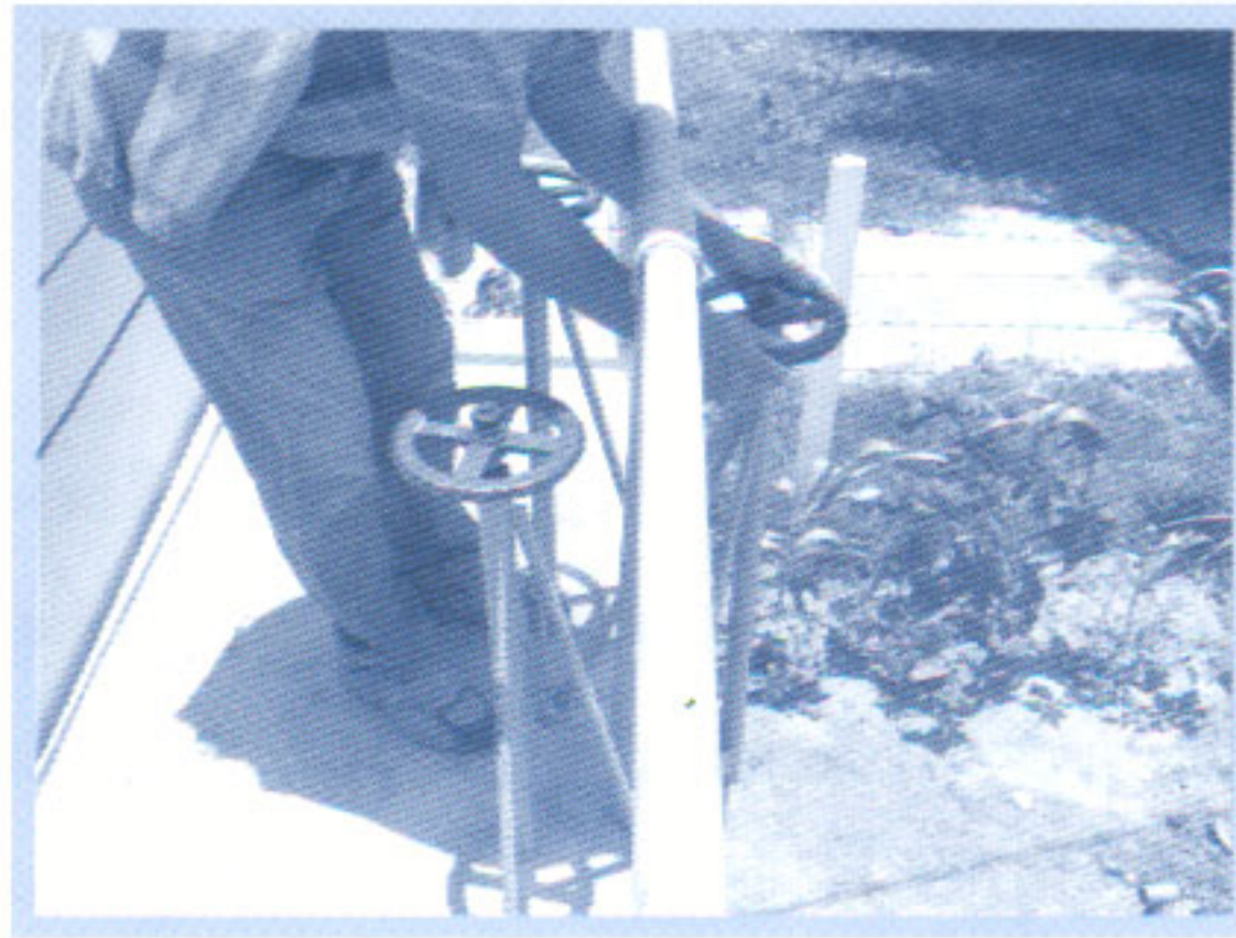
รูปที่ 53 เปิดประตูน้ำจากถังกรองลงถึงน้ำใส (ประตูน้ำหมายเลข 3)
