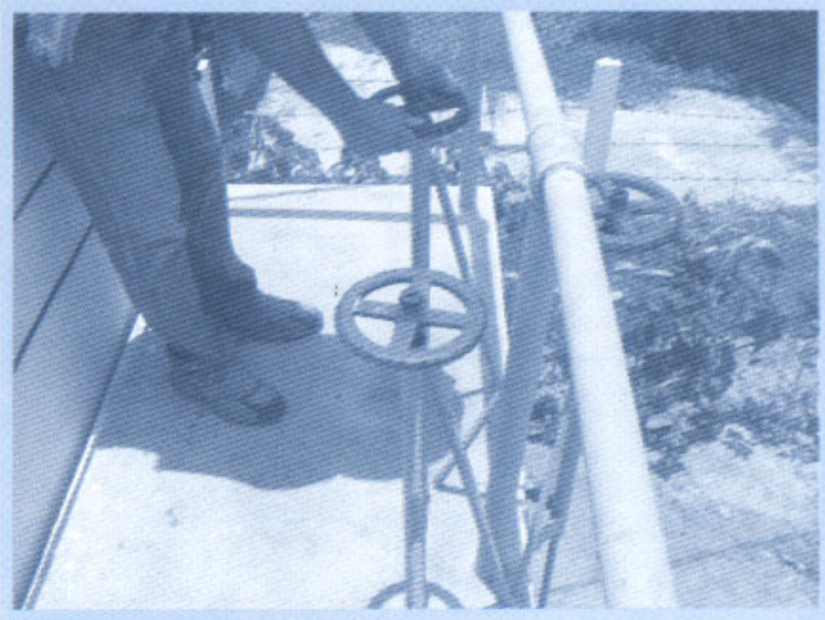
รูปที่ 59 เปิดประตูระบายน้ำทิ้งจากพื้นถังกรอง (ประตูน้ำหมายเลข 4)
