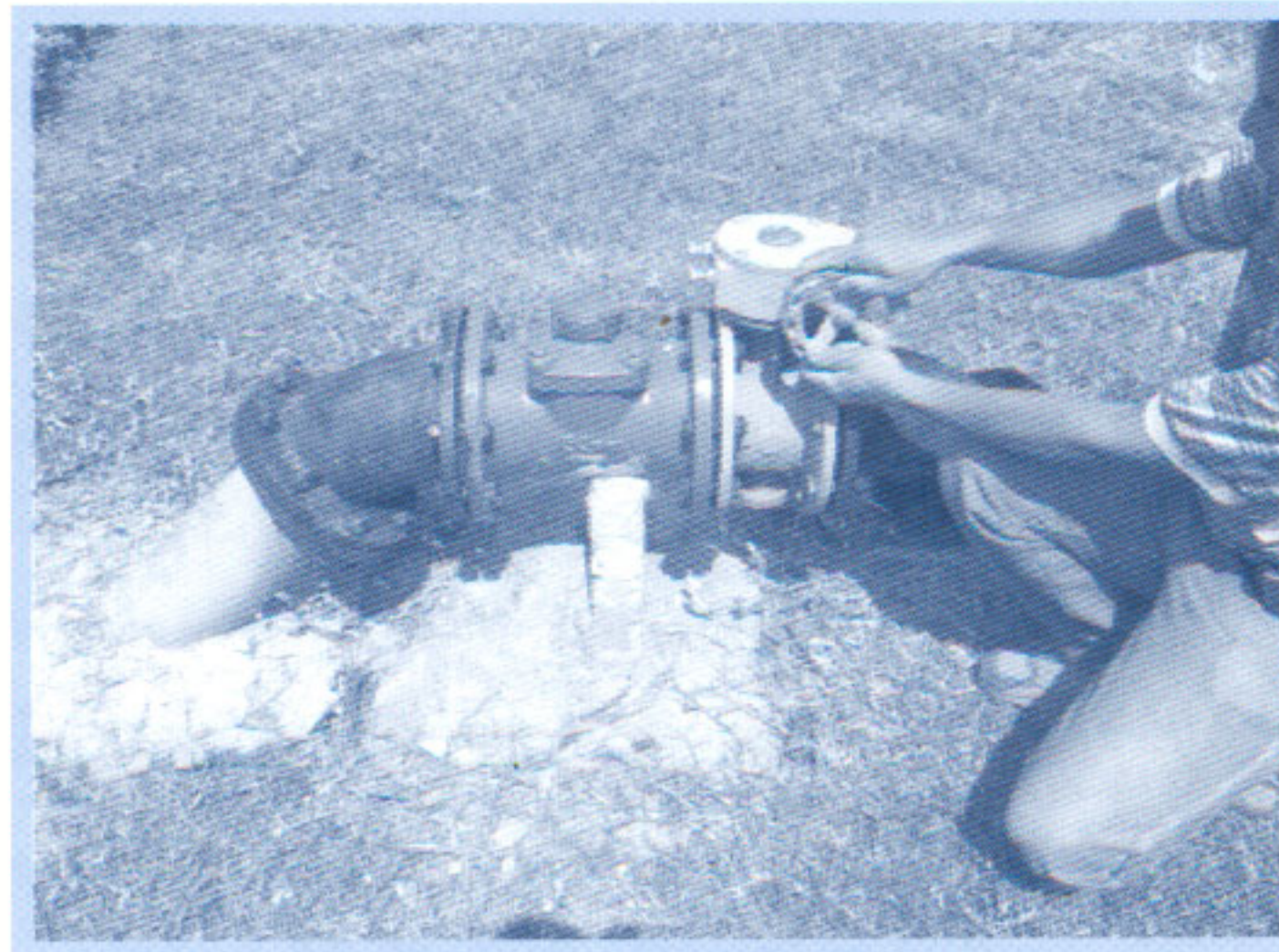
รูปที่ 56 เปิดประตูน้ำจ่ายน้ำประปา (ประตูน้ำหมายเลข 1)
