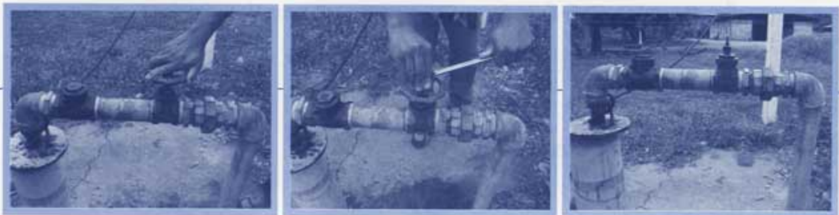
รูปที่ 20 การปรับประตูจ่ายน้ำเข้าสู่ระบบกรองและประตูจ่ายน้ำที่ถอดพวงมาลัยแล้ว
