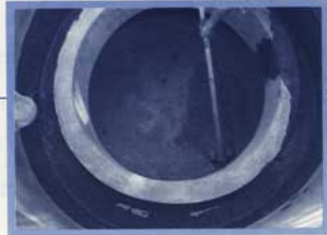
รูปที่ 65 การใช้จอบคุ้ยหน้าทรายกรอง
