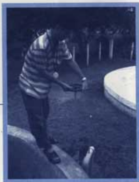
รูปที่ 66 เปิดประตูน้ำจากท่อถังสูงเข้าถังกรอง (ประตูน้ำหมายเลข 2)
