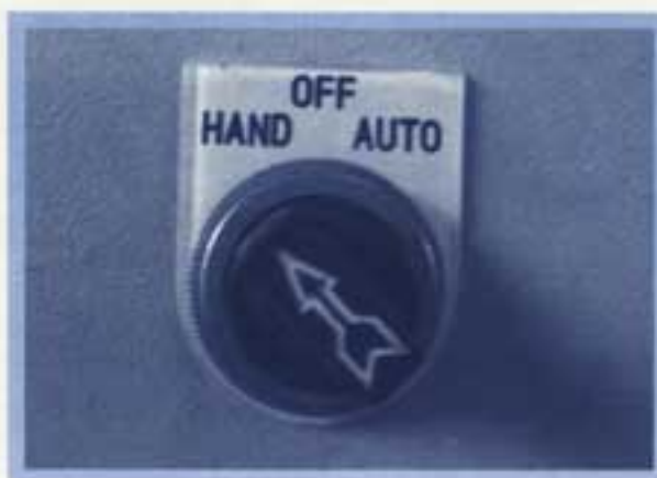
รูปที่ 46 สวิตช์ลูกศรที่ตำแหน่ง "HAND"
