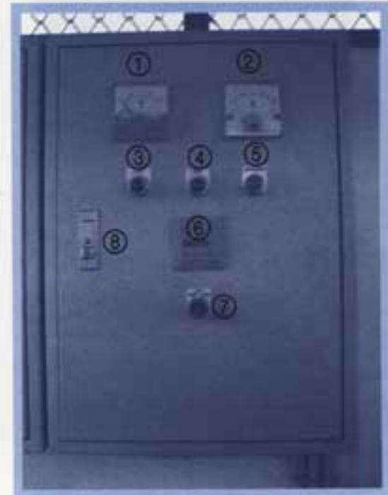
ลักษณะภายนอกตู้ควบคุมเครื่องสูบน้ำดิบ (แบบจมใต้ฟ้า)
