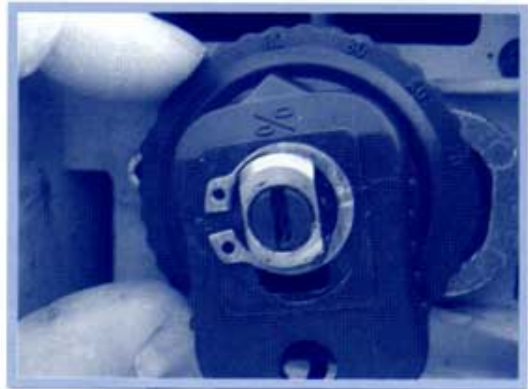
รูปที่ 30 การปรับอัตราการจ่ายสารละลายคลอรีนที่ประมาณ 80%
