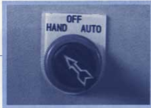
รูปที่ 12 สวิตช์ลูกศรที่ตำแหน่ง "HAND"
