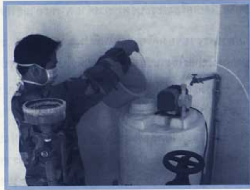
รูปที่ 33 การเติมสารละลายคลอรีนลงในถังจ่ายสารละลายคลอรีน
