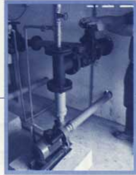
รูปที่ 58 ปิดประตูน้ำด้านท่อจ่ายน้ำ ของเครื่องสูบน้ำดี
