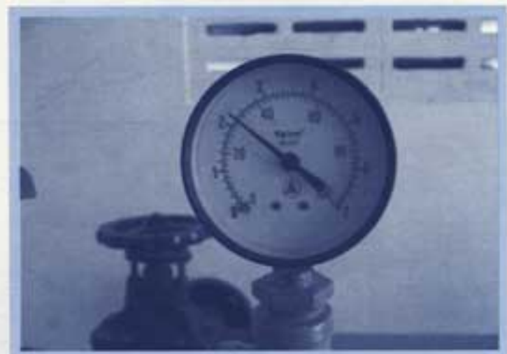
รูปที่ 50 เข็มของเกจวัดแรงดันจะแสดงการทำงานของเครื่องสูบน้ำ
