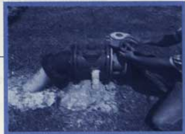
รูปที่ 61 ปิดประตูน้ำจ่ายน้ำประปา (ประตูน้ำหมายเลข 1) ➡
