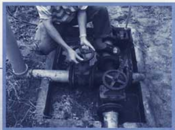
รูปที่ 57 เปิดประตูน้ำลงถังน้ำใส (ประตูน้ำหมายเลข 3) ➡
