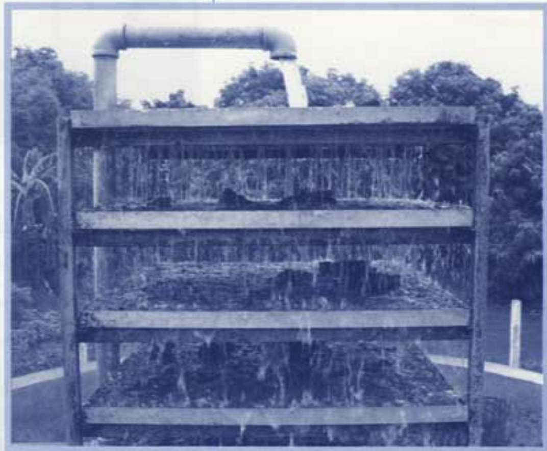
รูปที่ 21 ระบบเติมอากาศ
