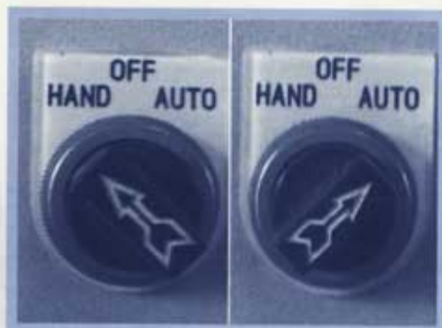
รูปที่ 77 ขั้นตอนการเริ่มต้นทำงานหลังเกิดการทริปเนื่องจากการลัดวงจรไฟฟ้า โดยเบรกเกอร์
