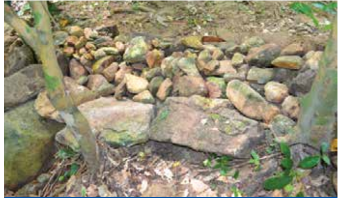
ฝายหินชะลอน้ำ เขายายดา จ.ระยอง
