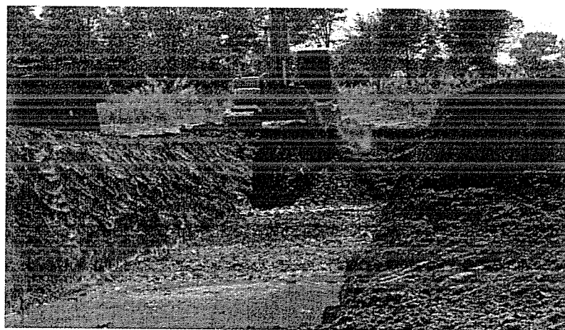
รูปที่ 3 การขุดดินร่องแกน
