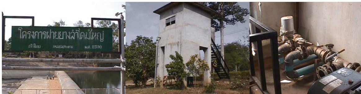
รูปที่ 4.1-8 แสดงห้องควบคุมการทำงานแบบไม่มีห้องใต้ดิน โครงการฝายยางลำโดมใหญ่ จ.อุบลราชธานี
