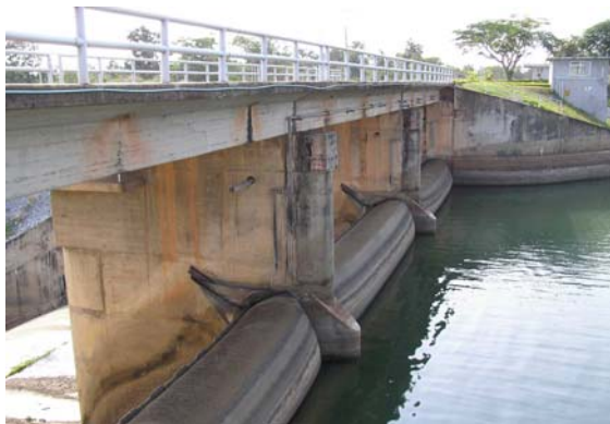
รูปที่ 4.1-3 แสดงการติดตั้งฝายยางของอ่างเก็บน้ำลำปาว จ.กาฬสินธุ์
