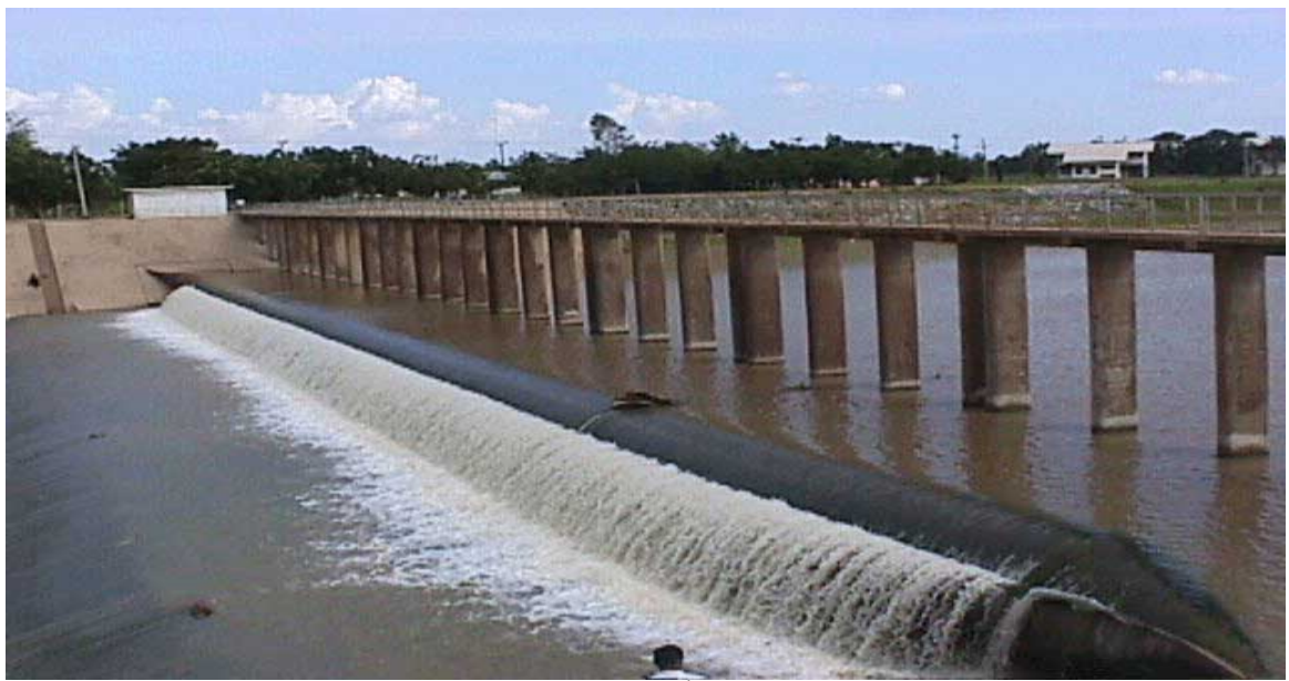
รูปที่ 4.1-2 แสดงการติดตั้งฝายยางบนฝายแข็ง
