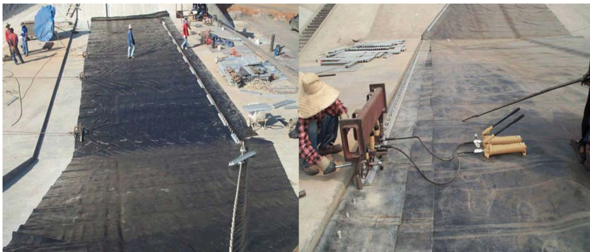
รูปที่ 4.1-1 แสดงการติดตั้งฝายยางบนฐานคอนกรีต
