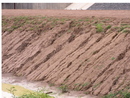
รูปที่ 32 ดินที่ใช้ก่อสร้างไม่เป็นไปตามข้อกำหนด ทำให้เกิดการกัดเซาะได้ง่าย
