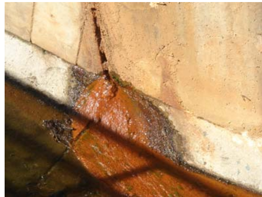
รูปที่ 27 น้ำซึมผ่านช่วงรอยต่อคอนกรีต
