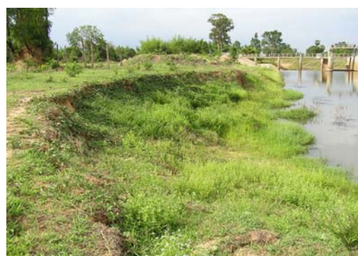
รูปที่ 34 การทรุดตัวของคันดินที่ก่อสร้างไม่ถูกต้อง
