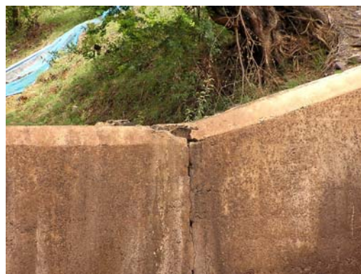
รูปที่ 37 การชำรุดของกำแพงกันดินด้านท้ายน้ำ
