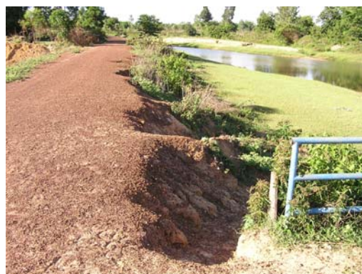
รูปที่ 32 ดินที่ใช้ก่อสร้างไม่เป็นไปตามข้อกำหนด ทำให้เกิดการกัดเซาะได้ง่าย
