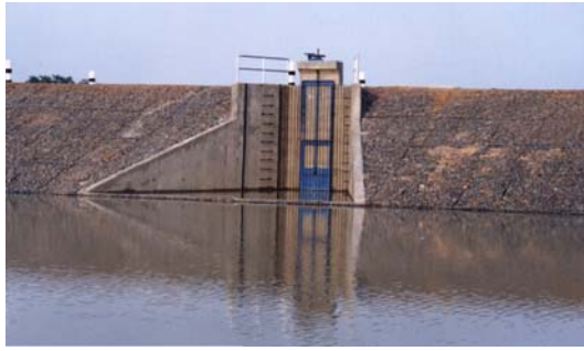
รูปที่ 8 รูปอาคารบังคับน้ำแบบความสูงของหัวน้ำไม่เกิน 3 ม. และเกินกว่า 3 ม. พร้อมอาคารคลุม
