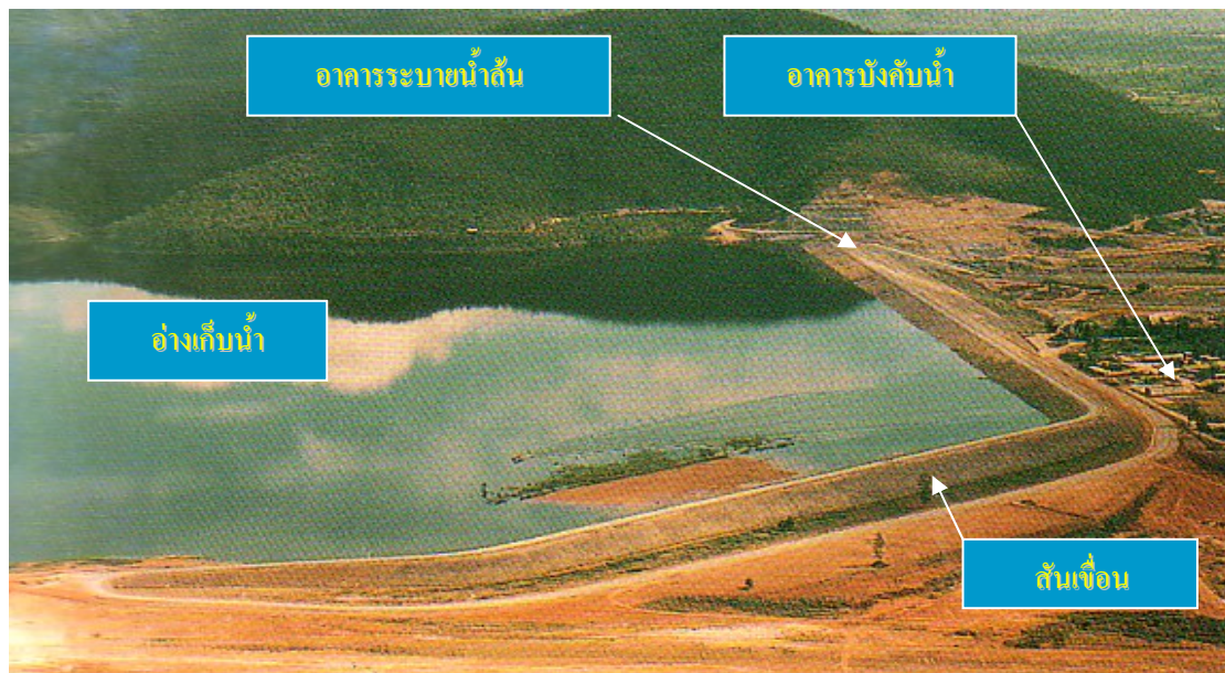
รูปที่ 1 แสดงลักษณะโครงการอ่างเก็บน้ำและส่วนประกอบอื่นๆ
