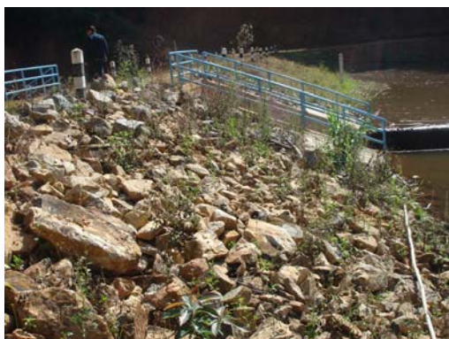
รูปที่ 29 ขนาดของหินไม่เป็นไปตามข้อกำหนด
