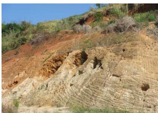
รูปที่ 33 การออกแบบตัดสันเขาไม่เหมาะสม
