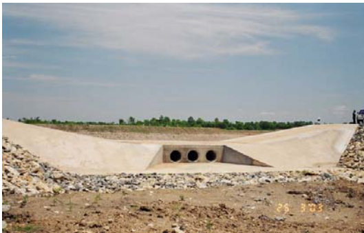
รูปที่ 14 รูปฝายน้ำล้นแบบสันกว้าง และแบบหินทิ้ง
