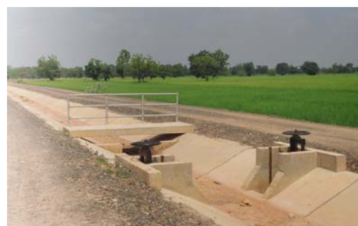
รูปที่ 20 รูปอาคารท่อลอดถนน และอาคารส่งน้ำเข้านา
