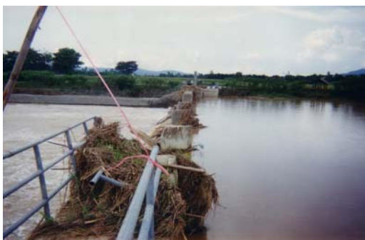
รูปที่ 36 การพังทลายเนื่องจากเศษสวะขวางลำน้ำ
