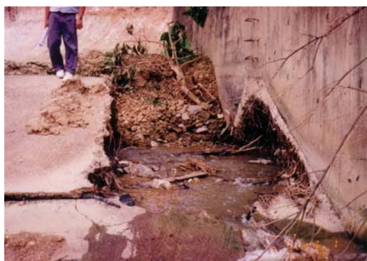
รูปที่ 28 ความเสียหายเนื่องจากน้ำล่อใต้อาคาร
