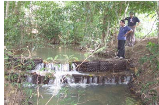
รูปที่ 14 รูปฝายน้ำล้นแบบสันกว้าง และแบบหินทิ้ง
