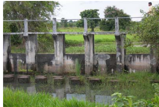
รูปที่ 13 รูปฝายน้ำล้นแบบสันมน และแบบตกรัง
