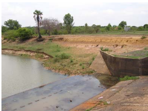
รูปที่ 37 การชำรุดของกำแพงกันดินด้านท้ายน้ำ
