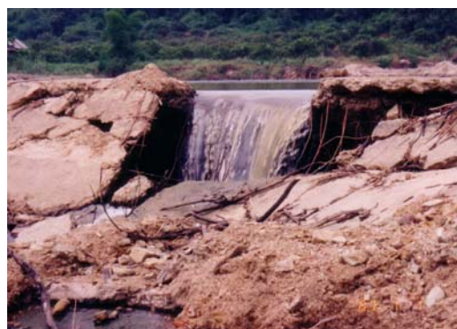
รูปที่ 28 ความเสียหายเนื่องจากน้ำล่อใต้อาคาร
