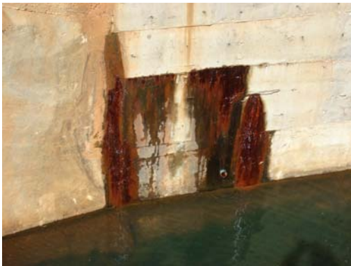
รูปที่ 27 น้ำซึมผ่านช่วงรอยต่อคอนกรีต
