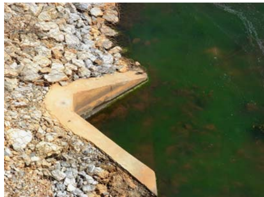
รูปที่ 29 ขนาดของหินไม่เป็นไปตามข้อกำหนด
