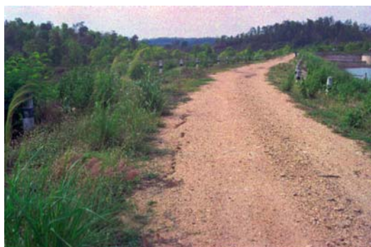
รูปที่ 26 การทรุดตัวของคันดิน
