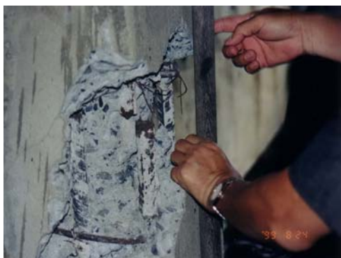
รูปที่ 30 คอนกรีตกะเทาะเนื่องจากเหล็กเป็นสนิม
