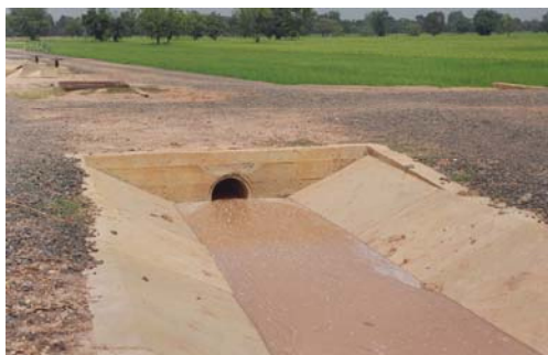
รูปที่ 20 รูปอาคารท่อลอดถนน และอาคารส่งน้ำเข้านา
