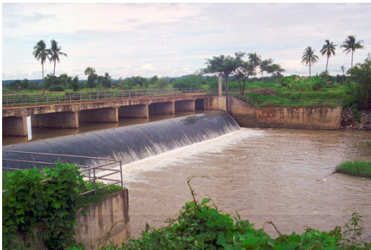
รูปที่ 13 รูปฝายน้ำล้นแบบสันมน และแบบตกรัง
