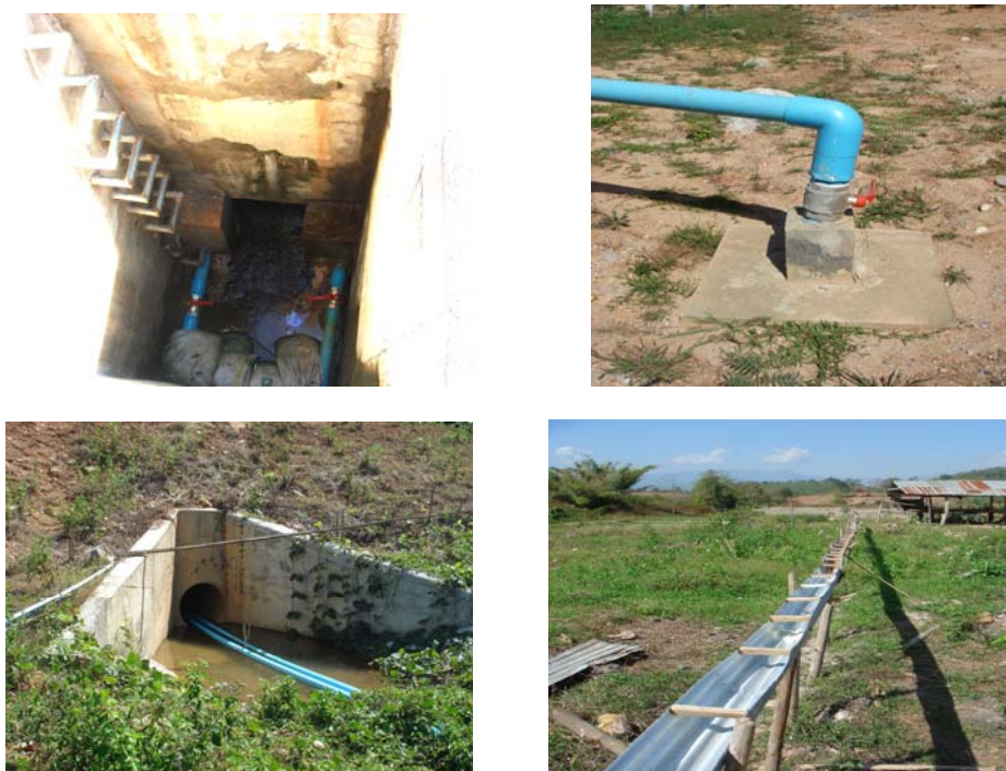
รูปที่ 35 การแก้ไข ดัดแปลงที่ไม่ถูกหลักวิชาการ
