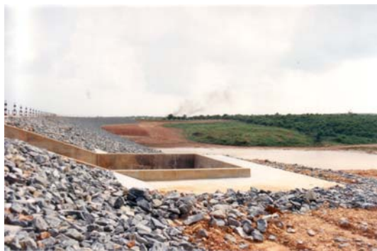
รูปที่ 6 รูปอาคารระบายน้ำแบบทางน้ำไหลเข้าเป็นกล่องและรางเท
