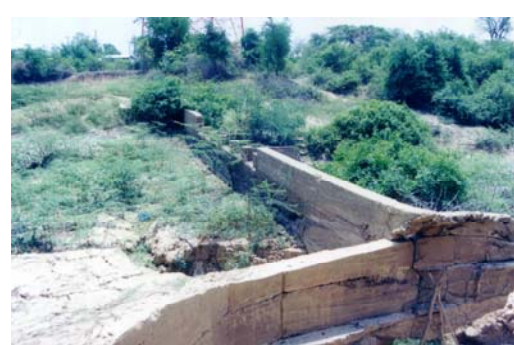
รูปที่ 47 รูปความเสียหายขั้นที่ 4 เพื่อการซ่อมสร้าง
