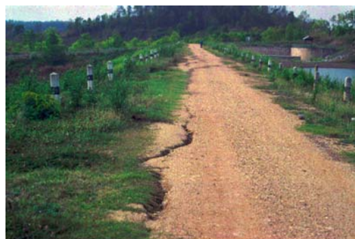
รูปที่ 26 การทรุดตัวของคันดิน
