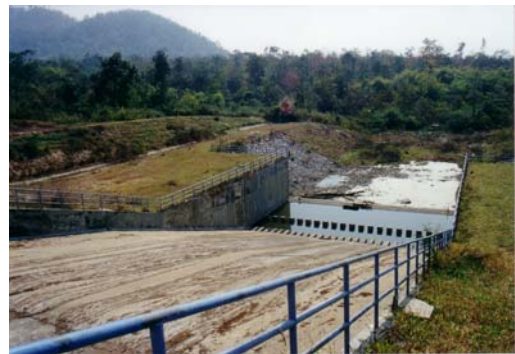
รูปที่ 6 รูปอาคารระบายน้ำแบบทางน้ำไหลเข้าเป็นกล่องและรางเท
