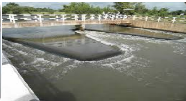
ฝายน้ำล้นแบบสັນหยัก(Labyrinth Weir)
