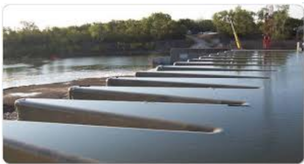
ฝายน้ำล้นแบบสັນหยัก(Labyrinth Weir)
