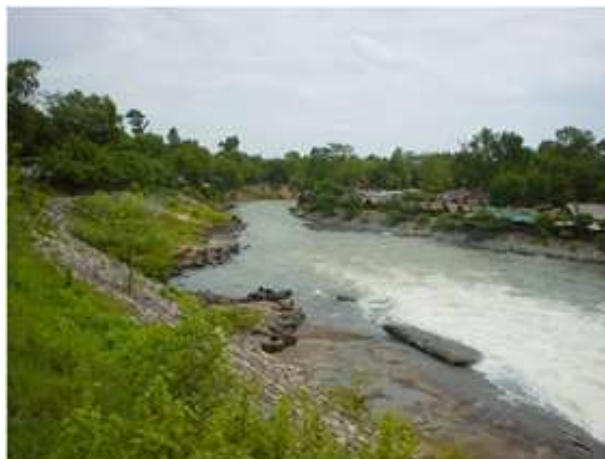
ท่อระบายน้ำลงลำน้ำท้ายเขื่อน (River Outlet)
