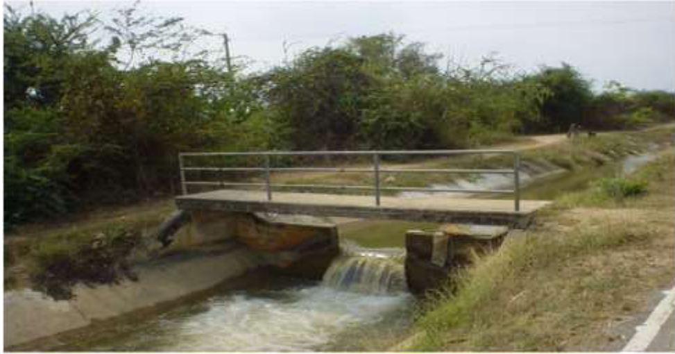
อาคารน้ำตก (Drop Structure)
