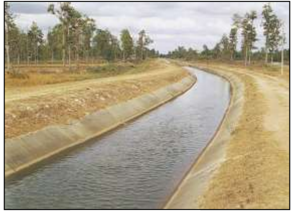
คลองตาดคอนกรีต
