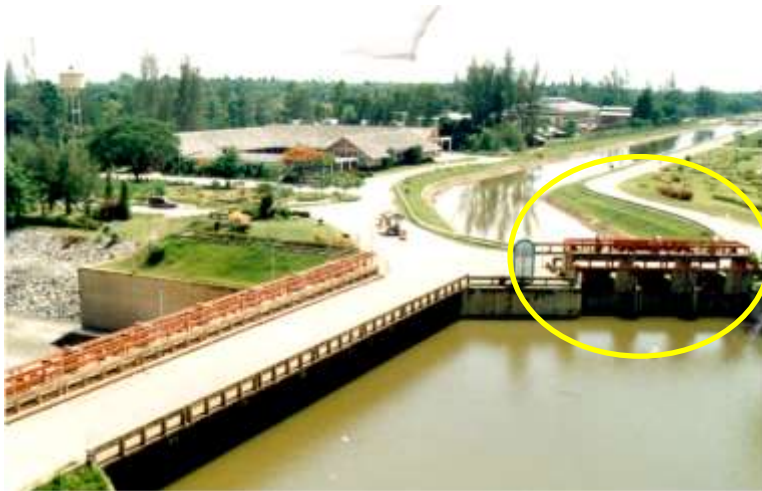
ประตูระบายน้ำปากคลองส่งน้ำ
