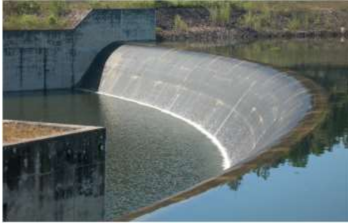
อาคารระบายน้ำล้นแบบโค้ง
