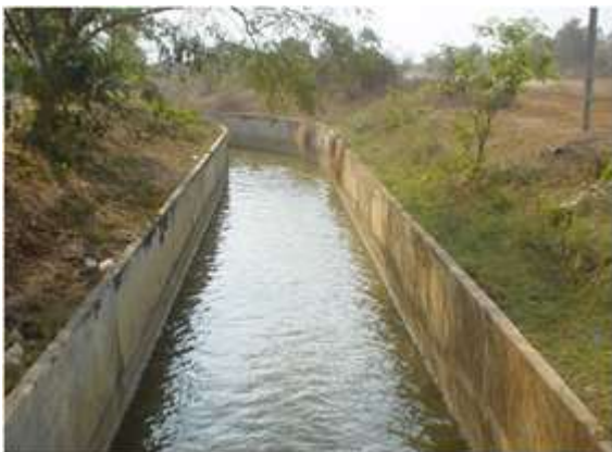
รางน้ำ (Bench Flume)
