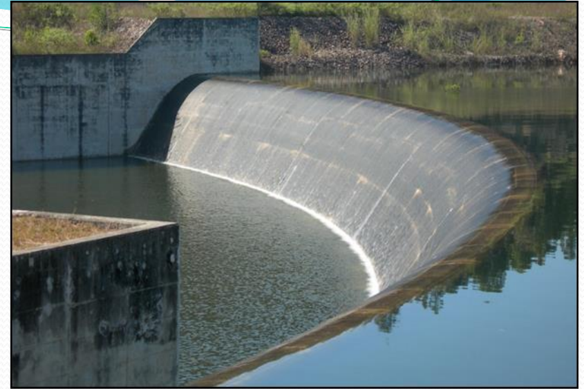
อาคารระบายน้ำล้นแบบโค้ง
