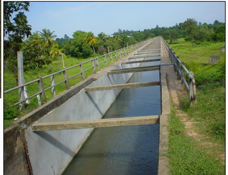
สะพานน้ำ (Elevated Flume)
