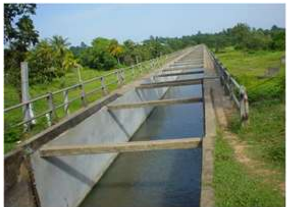
สะพานน้ำ (Elevated Flume)
