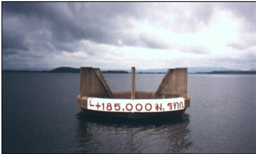
อาคารระบายน้ำล้นแบบ Morning Glory
