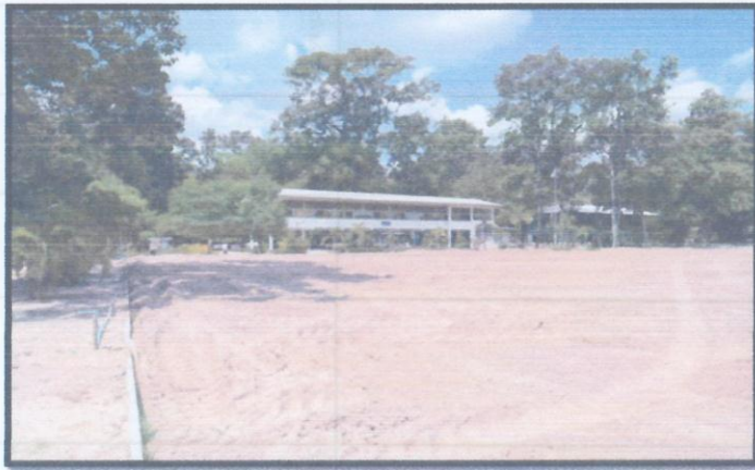
รูปถ่ายถมดินและปรับเกลี่ยเรียบร้อยแล้ว
