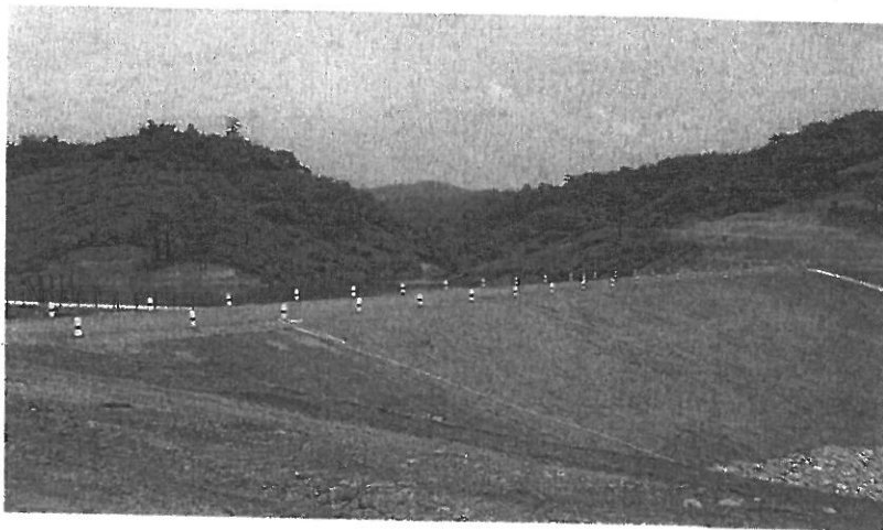
รูปที่ 18 แสดงการปลูกหญ้าลาดเขื่อนดิน
