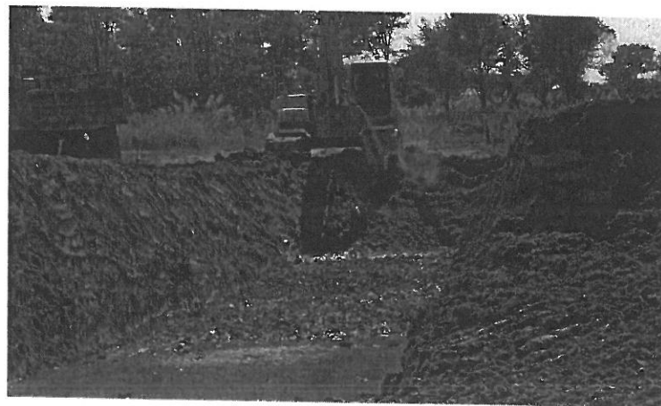
รูปที่ 3 การขุดดินร่องแกน
