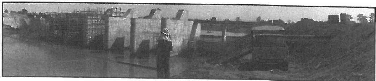
รูปที่ ๕ ภาพถ่ายในบ่อก่อสร้างและด้านท้ายน้ำ
