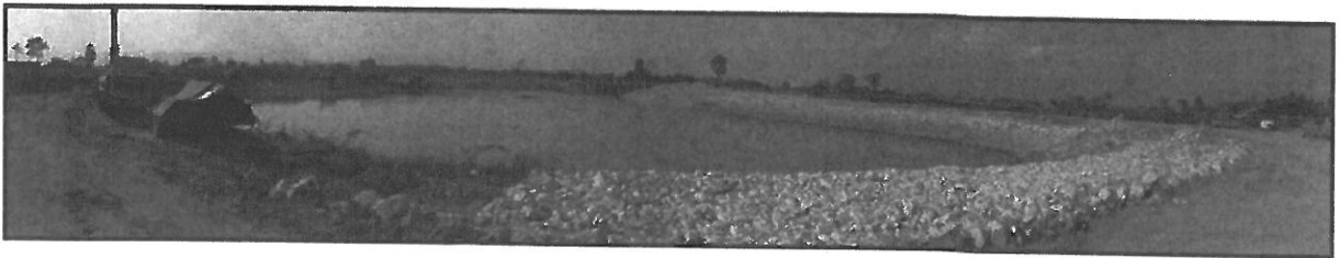
รูปที่ ๓ ภาพถ่ายด้านเหนือน้ำหลังจากขุดลอกและทำการป้องกันการกัดเซาะตามแบบแปลน
