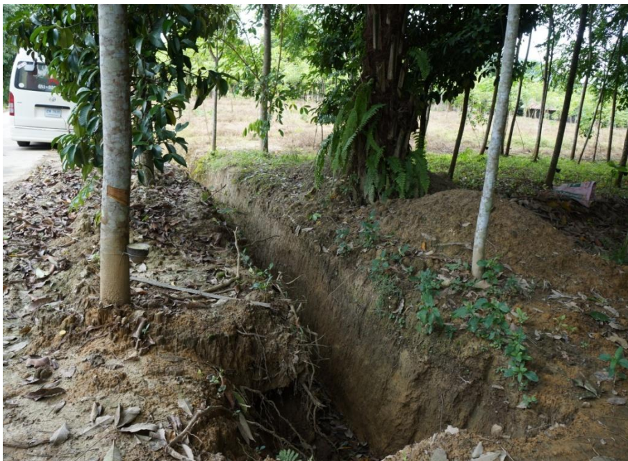
ภาพที่ 8.5 ทางระบายน้ำซึ่งถูกขุดลอกขึ้นใหม่ สำหรับบรรเทาปัญหาน้ำท่วมขัง ในพื้นที่ลุ่มต่ำของเทศบาลเมืองหลังสวน
