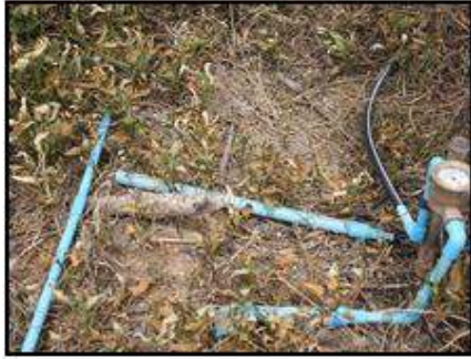
ภาพที่ 129 แนวท่อประปาที่เข้าหมู่บ้าน วางตามแนวถนน ทั้งสองฟาก ท่อน้ำประปาที่ต่อเข้ามิเตอร์ของทุกบ้านเพื่อตรวจสอบการใช้น้ำ
