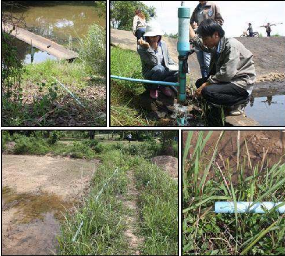
ภาพที่ 109 การส่งน้ำจากแหล่งน้ำต้นทุนสู่พื้นที่การเกษตรด้วยเครื่องตะบันน้ำ
