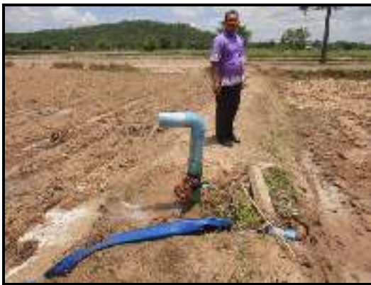
ภาพที่ 36 วาวเปิด-ปิดระบบส่งน้ำ
