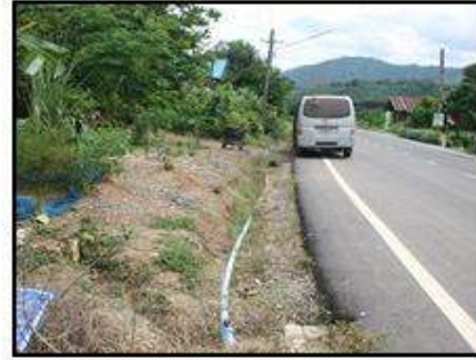
ภาพที่ 129 แนวท่อประปาที่เข้าหมู่บ้าน วางตามแนวถนน ทั้งสองฟาก ท่อน้ำประปาที่ต่อเข้ามิเตอร์ของทุกบ้านเพื่อตรวจสอบการใช้น้ำ
