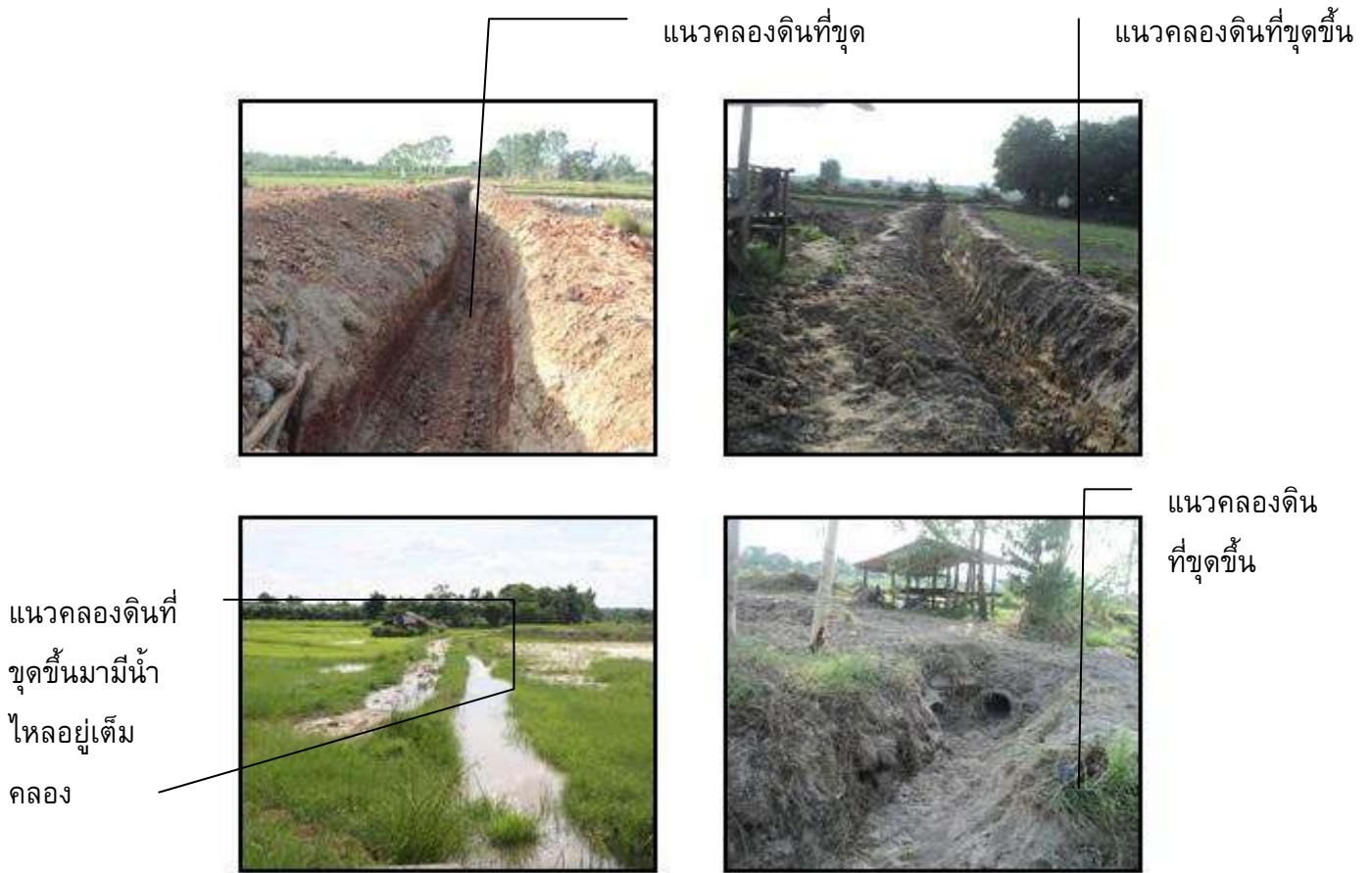
ภาพที่ 53 แนวคลองดินที่ขุดขึ้น โดยจะขนานไปกับที่นาของชาวบ้าน เพื่อให้สะดวกในการนำน้ำเข้านา
