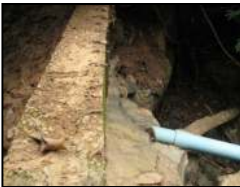
ภาพที่ 132 ตัวฝายกันเป็นคอนกรีตสูง 150 ซม.
