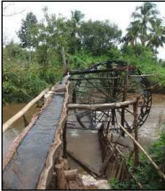
ภาพที่ 112 การทำงานของพัดน้ำ
