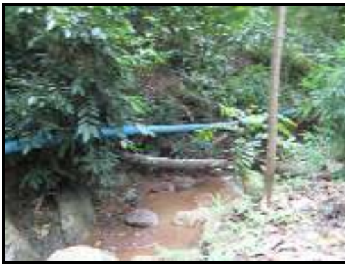
ภาพที่ 131 การเดินท่อ PVC ประปาห้วยทองใหญ่ (ซ้าย) และจุดก่อสร้างฝายชะลอน้ำ (ขวา)
