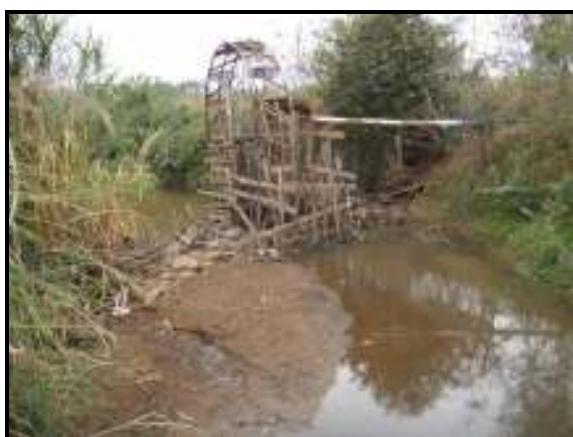
ภาพที่ 111 พัดน้ำในฤดูแล้ง และรอปรับปรุงในฤดูฝน
