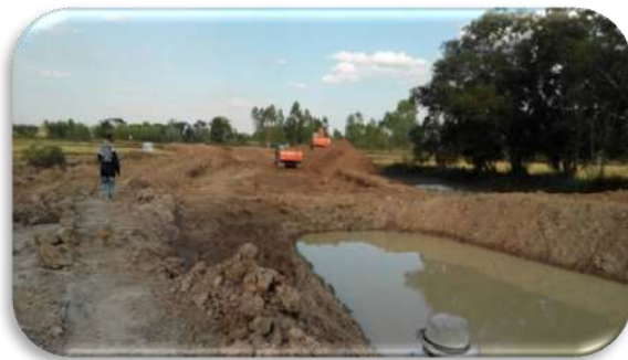
ภาพถ่ายโครงการระหว่างดำเนินการ
