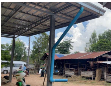
รูปตัวอย่างรางน้ำฝนและท่อน้ำ
