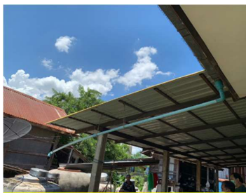
รูปตัวอย่างรางน้ำฝนและท่อน้ำ
