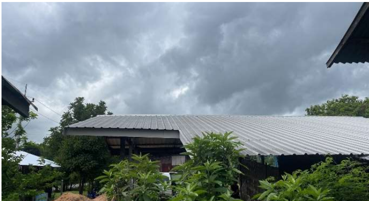
รูปตัวอย่างหลังคาที่ผ่านการทำความสะอาด
